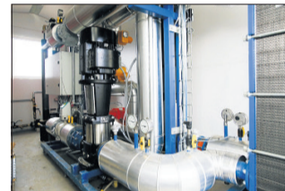
Det store solvarmeanlæg giver miljøvenlig fjernvarme. Foto: Kenn Thomsen
