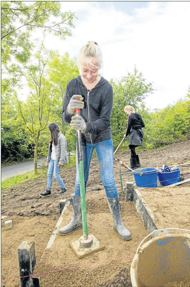
Gruset skal bankes fast på trappetrinene. Foto: Bjørn Armbjørn
